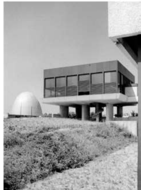
Neubau des Physik-Departments 1970, Ansicht Bibliothek mit Atomel
