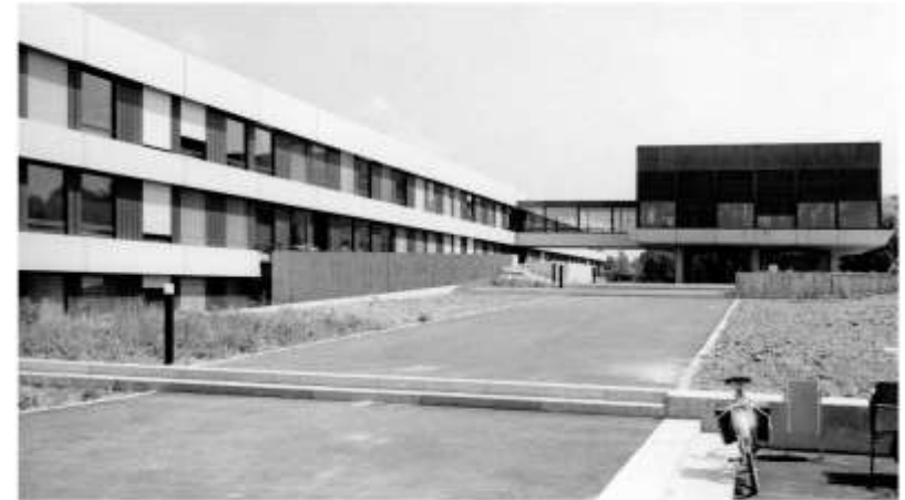
Neubau des Physik-Departments auf dem Campus Garching 1970, Haupteingang James-Frank-Straße
